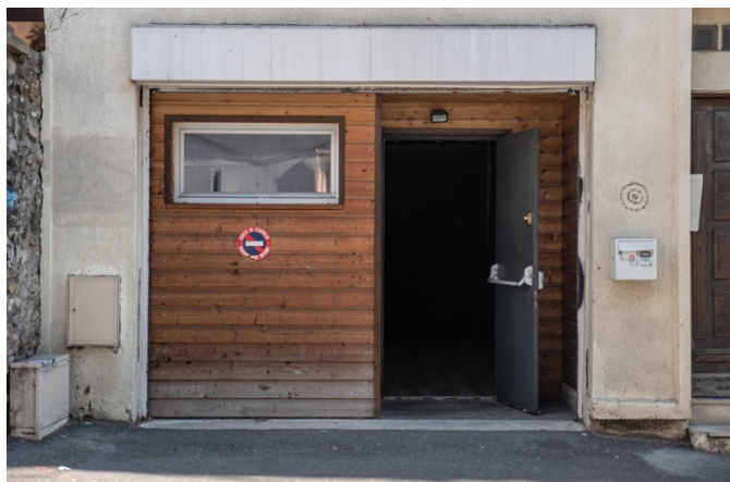
Accès technique de plain-pied – 1UP (L 0,90m / H 2,12m)
